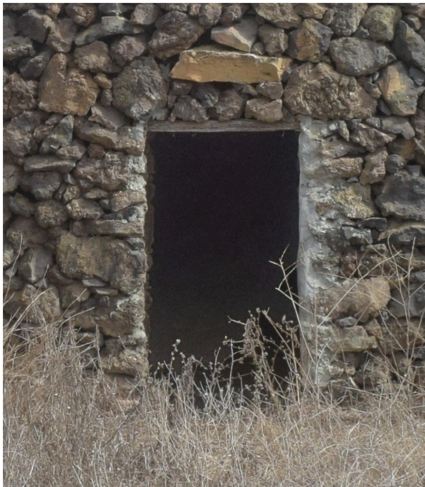
Abb.10 - Rezente Cabaña östlich von Máguez, Lanzarote: glattflächig ausgeführter Eingang, der zum Teil verputzt ist (Photo: Hans-Joachim Ulbrich). Über dem Türsturz aus Holz wurde – wohl aus alter Sitte heraus – ein Querstein eingebaut, wie er früher für den oberen Abschluss des Eingangs verwendet wurde (siehe Abb. 9).
