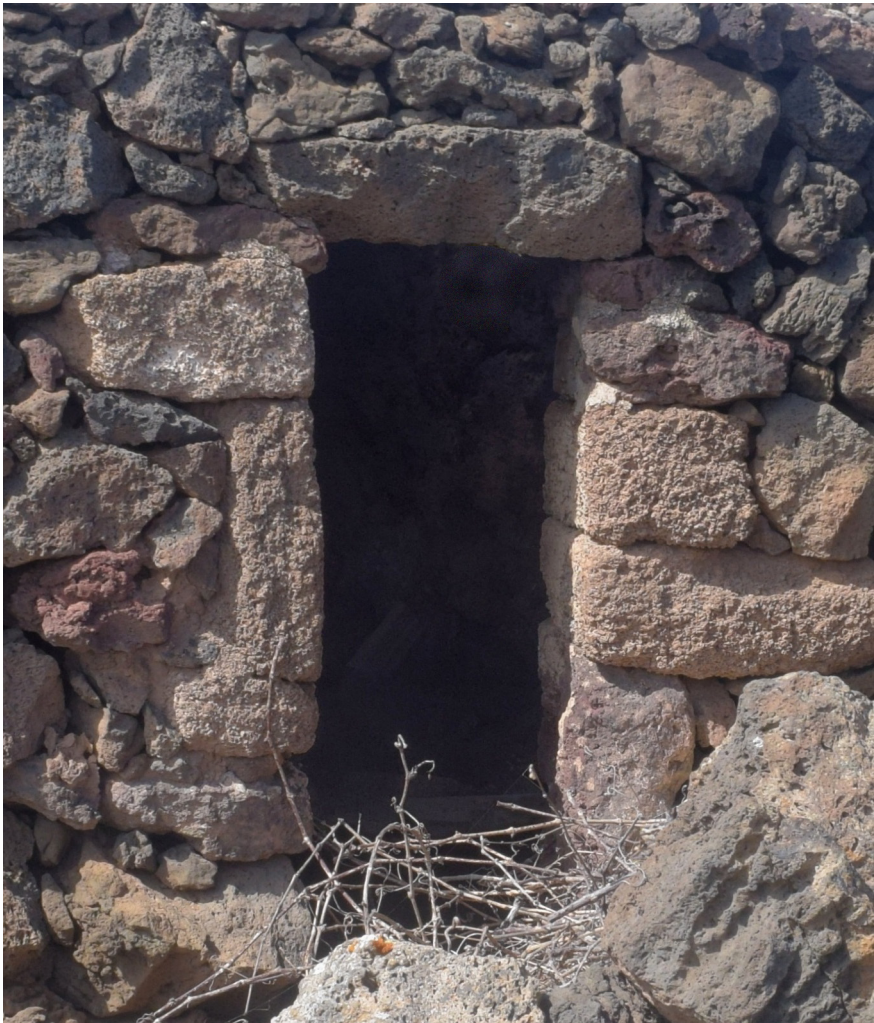
Abb.9 - Rezente Cabaña westlich von Tinajo, Lanzarote: glattflächig ausgeführter Eingang (Photo: Hans-Joachim Ulbrich).
