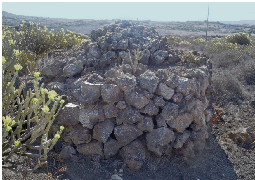
Abb.7 - Trockensteinbau bei Máguez (Lanzarote), Westseite. Links im Bild die Nordseite mit den erwähnten Beschädigungen (Photo: Hans-Joachim Ulbrich).
